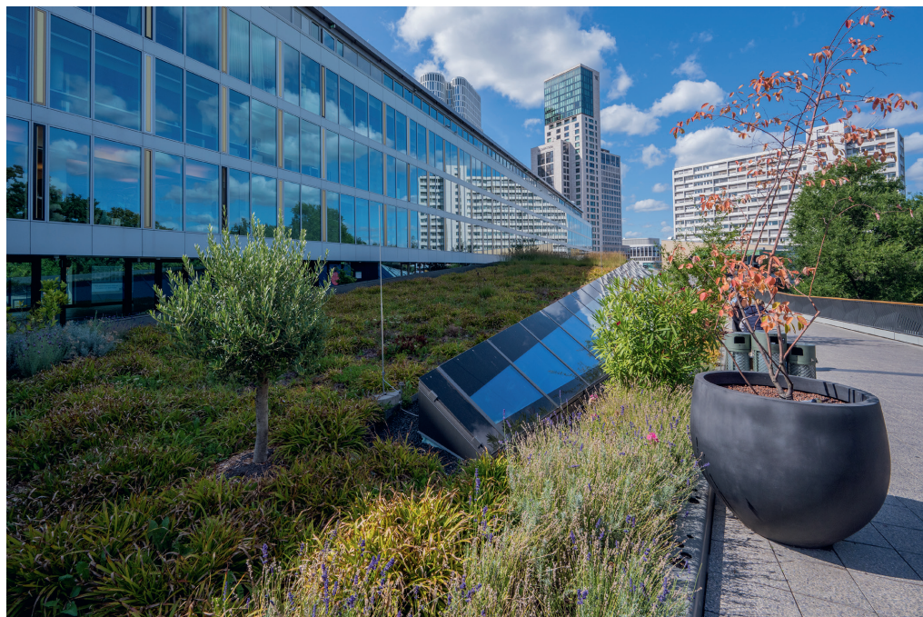
Abb. 9: Intensive Dachbegrünung auf dem BIKINI BERLIN
